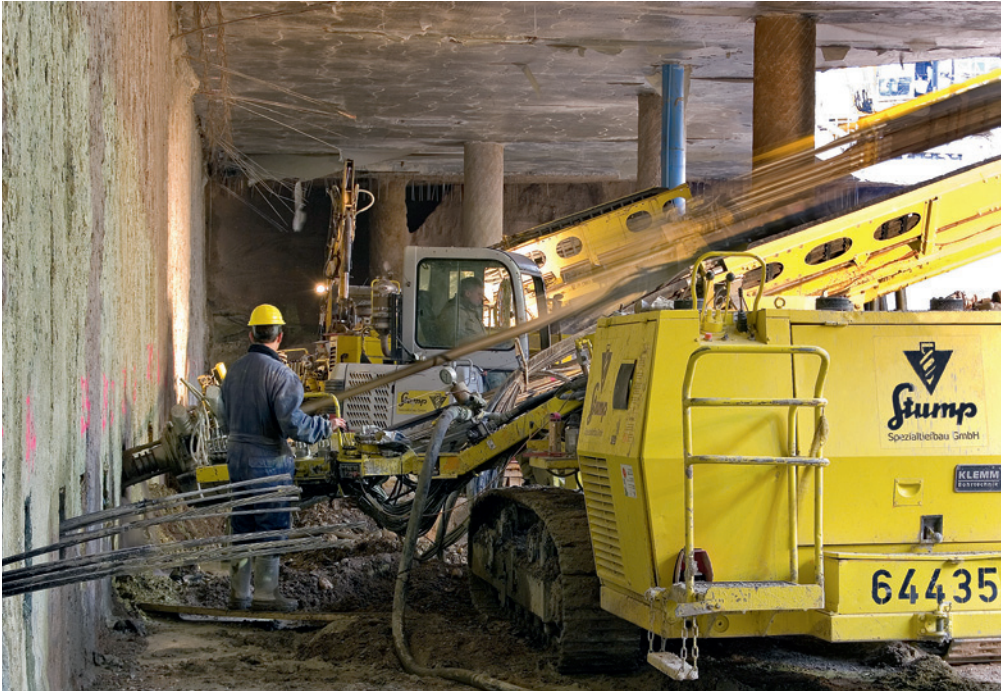
BV: Düsseldorf, Ankerarbeiten gegen drückendes Wasser
